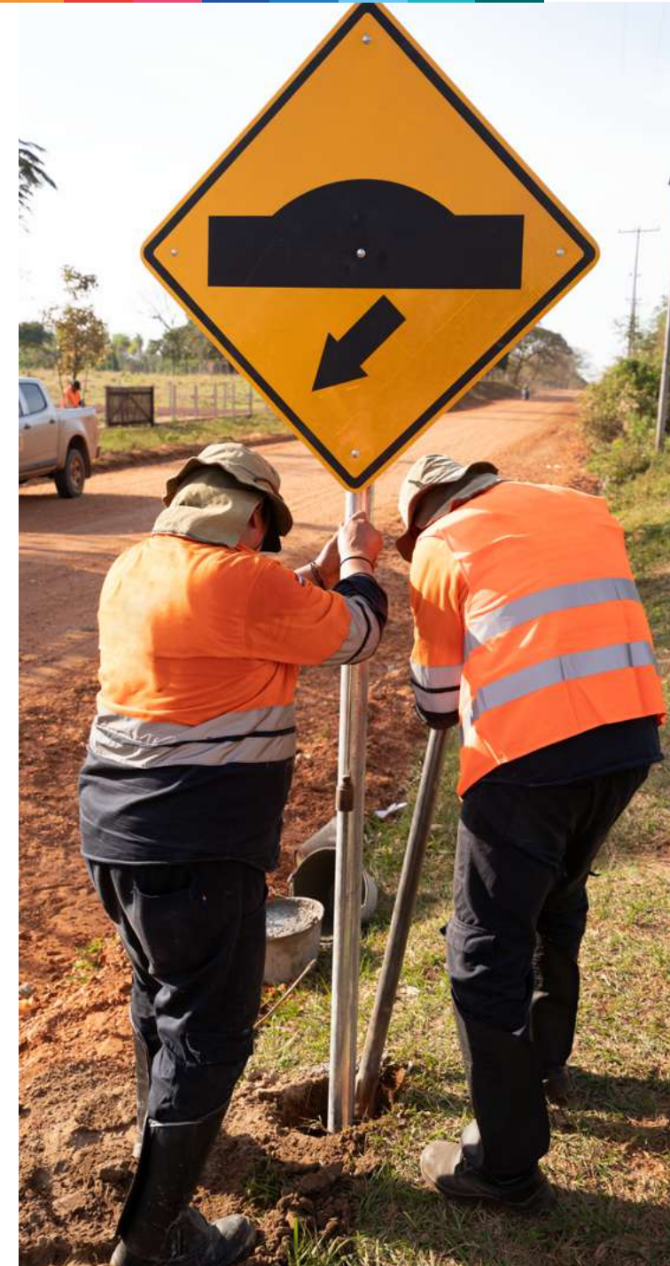
Colocación de carteles viales | Área de Influencia del componente Industrial.
